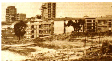
Fig. 33: Fotografia do bairro dos Pinheirinhos em construção
