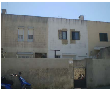
Fig. 78: Alteração feita nas janelas
