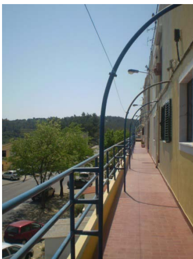
Fig. 81: Galerias de segundo piso dos blocos habitacionais
