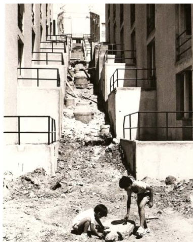
Fig. 64: Escadaria entre blocos em obra
