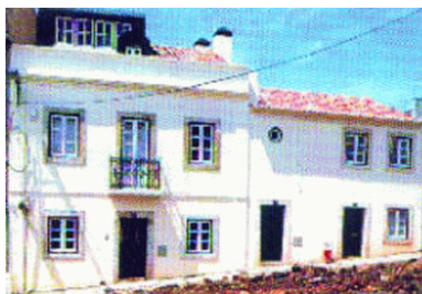
Fig. 14: 1º Prémio RECREIA 2000 (depois da intervenção)
