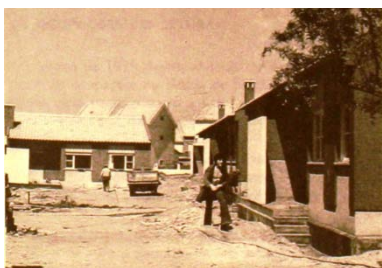
Fig. 44: Fotografia da construção do bairro da Terroa de Baixo
