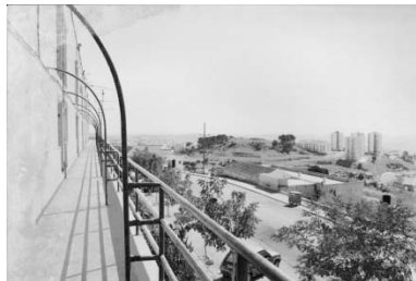
Fig. 63: Varandas blocos com entrada para a sala de um T3
