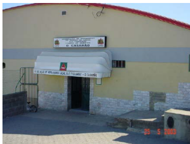
Fig. 87: Centro de convívio "Casarão" Fonte: clientes.netvisao.pt (Setembro 2011)
