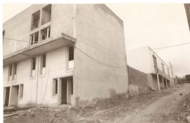
Fig. 62: Habitações do bairro em construção
