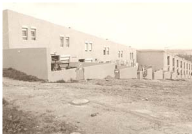
Fig. 61: Bloco habitacional do bairro do Casal das Figueiras
